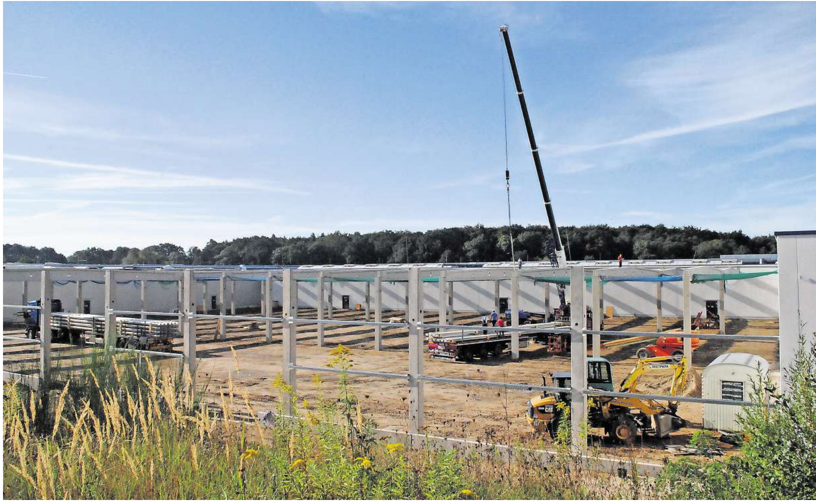
Derzeit wird die Trägerkonstruktion für die neue Produktionshalle montiert.
